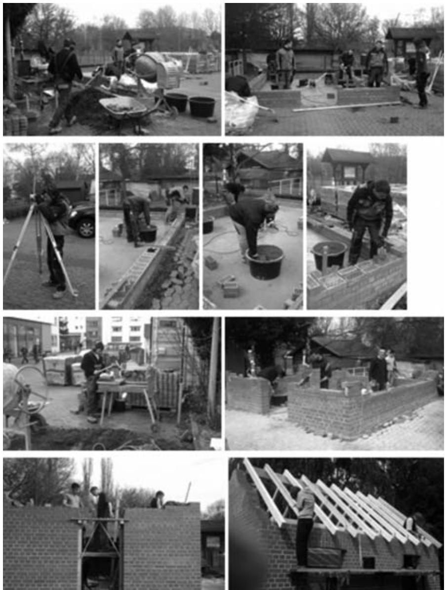
Abb.: Momentaufnahmen beim Bau des Backhauses
